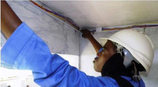
Aïnou en plein chantier
